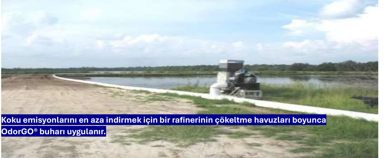
Büyük çökeltme havuzlarının etrafında bir OdorGO® buhar fazlı sistemi kullanılır.
